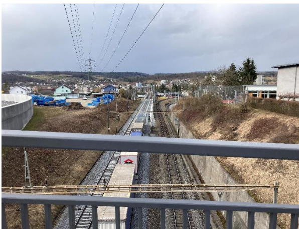
Abbildung 2: Blick von der Habsburgbrücke auf die zu querende Bahnstrecke
