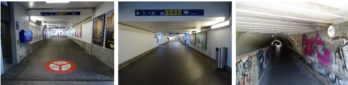
Abbildung 9: Impressionen Unterführungen (Campus Passage, PU Mitte, Süssbachunterführung)
